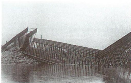
01.09.1939 r. Wysadzone pierwsze przęsło mostu kratownicowego, przełamano się w pół i wpadło do nurtu Wisły.
