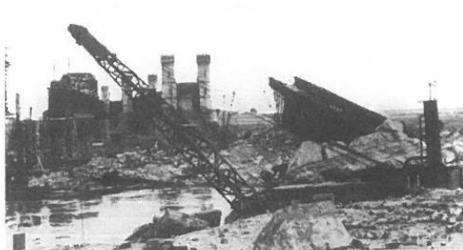
Wrzesień 1939 r. Niemcy przystępują do usuwania szkód i remontu mostów.
