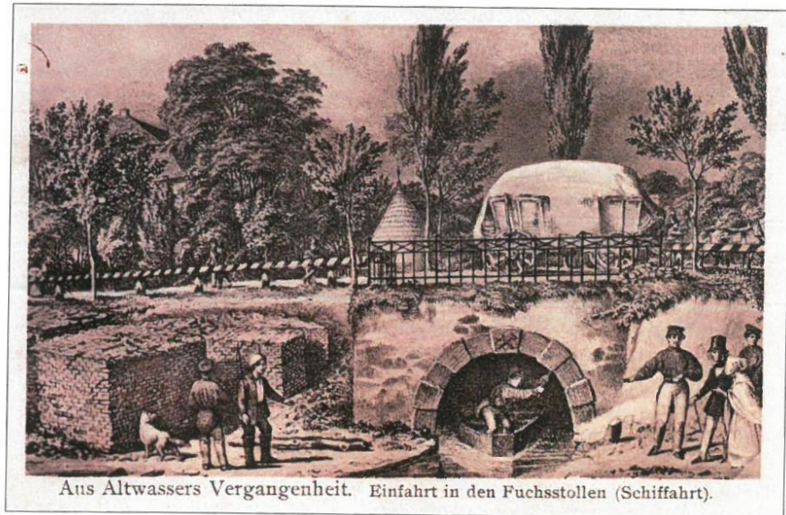
il. 2. „Lisia Sztolnia” - wylot drogi wodnej (widok z końca XVIII w.).
